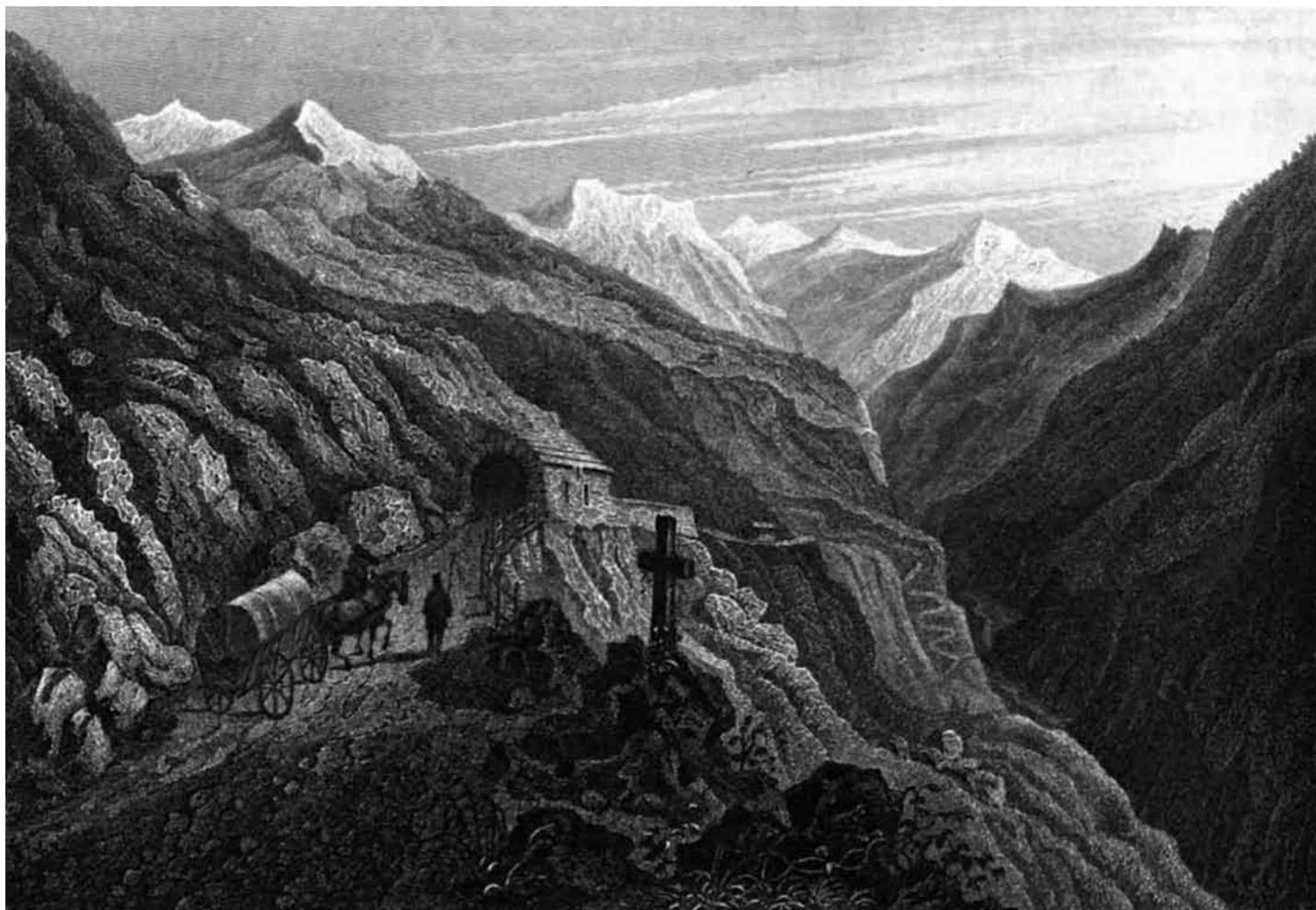
prima delle famose gallerie della strada dello Spluga. Costano di solidi muri di pietre squadrate che aderiscono alla roccia così da formare un tutt'uno con essa, tanto che la copertura delle volte sembra una continuazione del pendio. Sul lato del precipizio i muri sono sostenuti da pile molto robuste e sono provvisti di fenditure simili ad archibugiere
