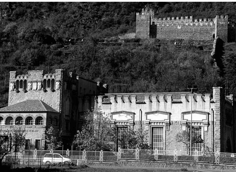
Castello di Grosio e Centrale idroelettrica
