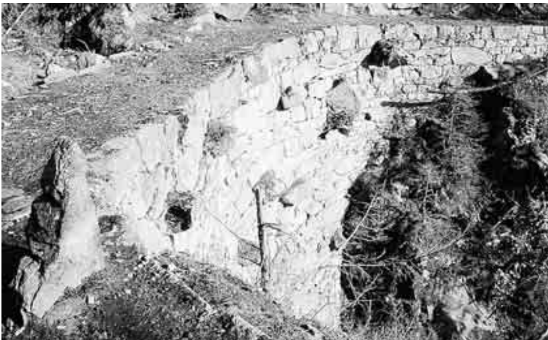
Il viadotto della valle Caspairola
